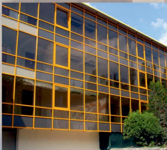
Толщина заполнения в конструкциях серии AGS 68E – от 1 до 61 мм. В основу системы заложен «Европаз».
